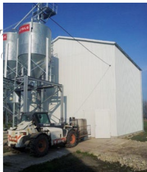
Funkció: Magkeverő épület Helyszín: Mezőberény Kivitelezés éve: 2011 Lindab termékek: szelemen és falvázgerenda, tető- és fal-trapézlemez, ereszcsonna
